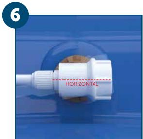
Para que a válvula funcione corretamente, ela deve ser instalada e nivelada de forma que fique em posição horizontal.
